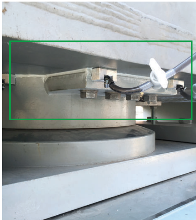
Kompensacja szczeliny w łożysku mostu, most Yavuz Sultan Selim, Stambuł, Turcja
